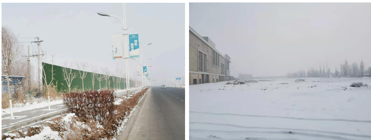
已完工彩钢板围挡和现场照片
